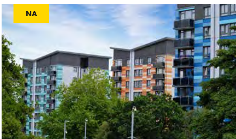
RENOVATIE CHARLEMONT FARM RESIDENTIE, VERENIGD KONINKRIJK.
